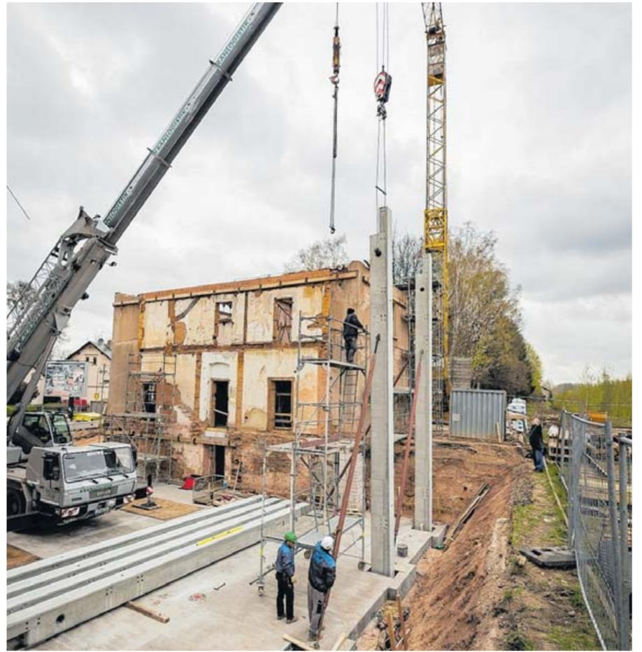
**Der Umbau des Lugauer Bahnhofs** zum Ort der Begegnung und Bewegung geht voran: Am Freitag sind die Stahlbetonträger angeliefert und eingesetzt worden. Mit einem Kran sind die Bauteile in die dafür vorgesehenen Aussparungen in der Bodenplatte gehoben
