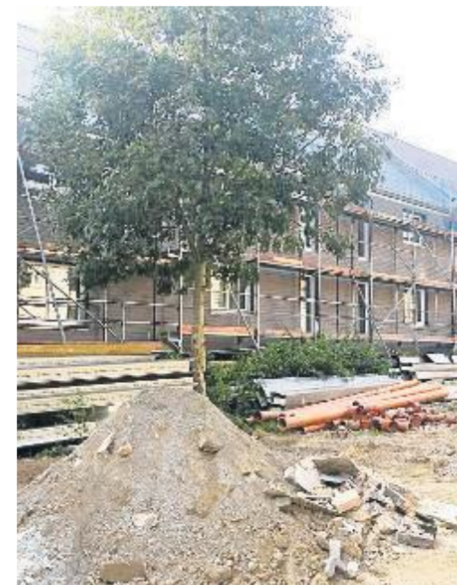
Fortschritt: die sanierten Häuser.
