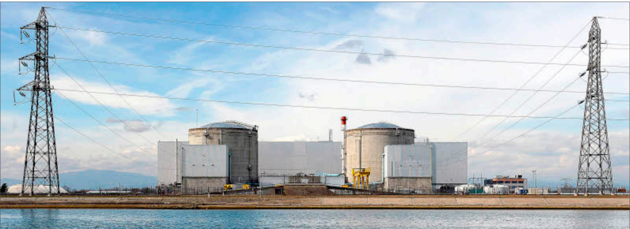
Bange Blicke richten sich aus Südbaden über den Rheinseitenkanal auf das Atomkraftwerk in Fessenheim, das älteste in ganz Frankreich.
