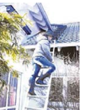
Steiler Aufstieg aufs Dach: Einen Schornsteinfeger bei der Arbeit zu fotografieren, sorgte für schlotternde Knie.
