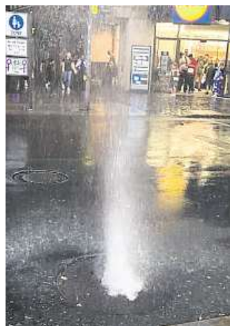
An der Ecke Luisenstraße/Kirchgasse sprudelt es aus der Kanalisation. Foto: Christopher Schäfer
