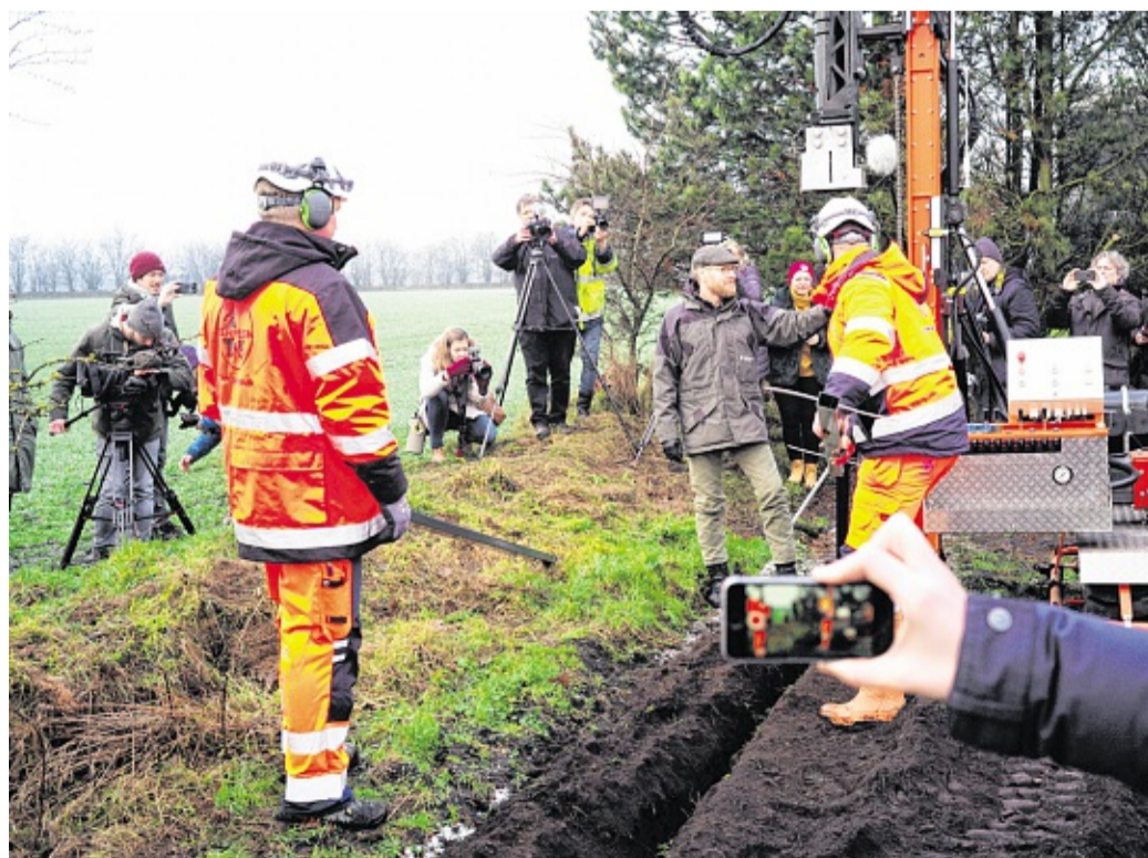
Punkt zehn Uhr wurde der erste Pfosten des 70 Kilometer langen Wildschweinzauns ins Erdreich gehämmert. Oberförster Bent Rasmussen (Bildmitte) gab das Signal.
