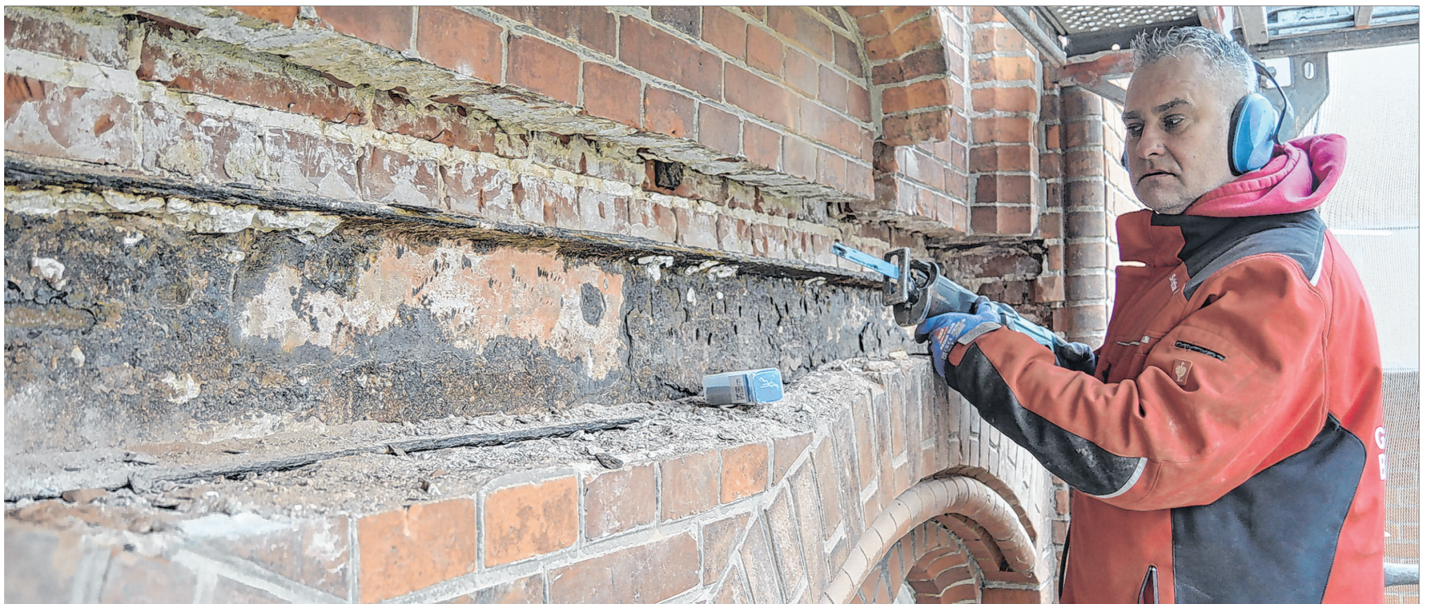
Ein Mitarbeiter der Firma Terfehr auf Borkum legt einen Stahlträger in der Aussenfassade der reformierten Kirche frei.
