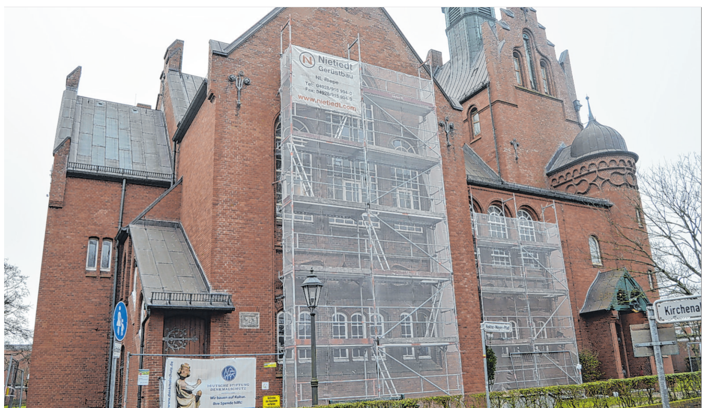
Die Fassade der Kirche ist rundum von Baugerüsten umgeben.
