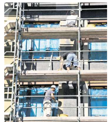
Geht ins Geld: Bauarbeiter beim Hausbau. FOTO: LOTHAR FERSTL/DPA
