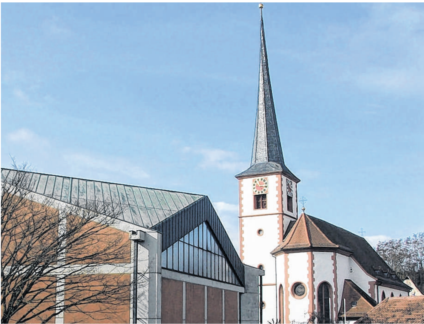
Früher gab es zwei katholische Kirchen in Himmelstadt: Hinten St. Jakobus, vorne St. Immina, die im Frühjahr 2010 abgerissen worden ist und einem neuen Pfarrzentrum wich.
